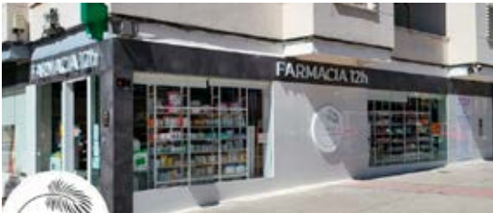
Fachada de Las Palmas Móstoles
